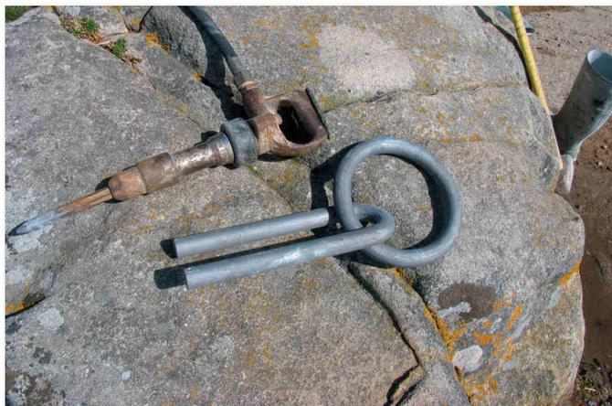
*Les deux extrémités de la bride d'organeau vont être sciées puis écartées avant d'être scellées entre deux pavés (le mot organeau désigne les deux pièces : la pièce ronde et la bride).*
