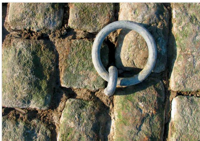
*L'organeau -en acier galvanisé à chaud- est installé sur la cale.*
