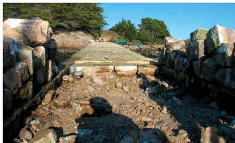
*Vue vers la terre. Les pierres de couronnement ont déjà été remplacées et les pavés positionnés sur les deux côtés de la cale afin de travailler sur le platelage.*
