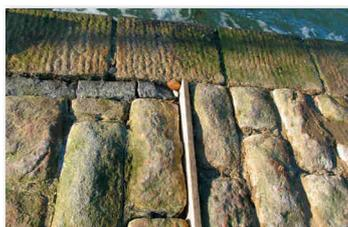
*Une planche de coffrage en bois sert à aligner et tenir les pavés avant leur scellement. Il délimite le joint en ciment.*
