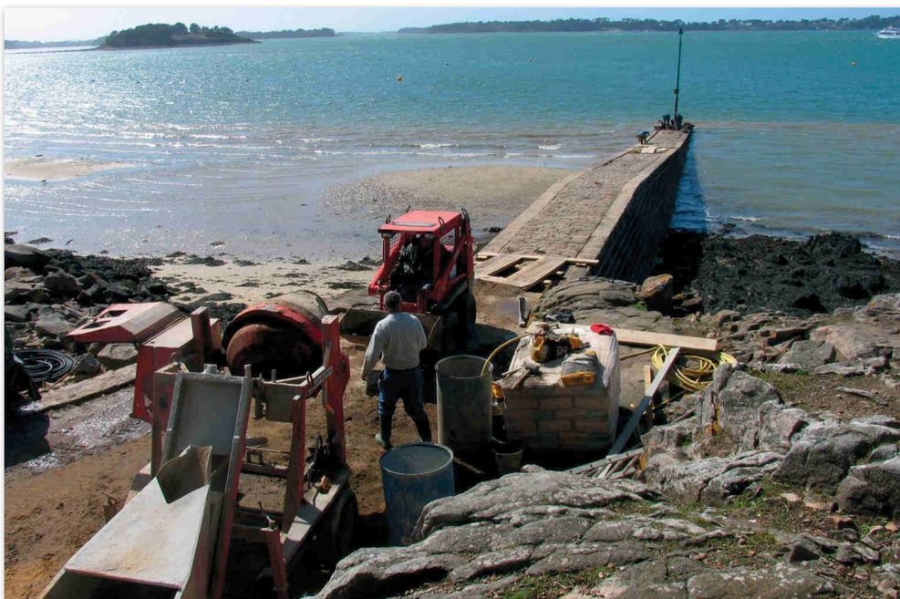
*Le chantier est installé en haut de cale où tous les matériaux peuvent être acheminés par la route. Pour les cales qui ont un accès impossible par la terre, il est nécessaire de venir avec un chaland, par la mer.*
