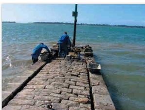
*Travaux sur le nez de la cale à marée basse. Réinstallation des pavés tenus à leurs bases par le mortier et, entre chaque pavé, par le ciment.*
