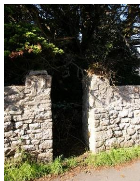
Un accès piéton
