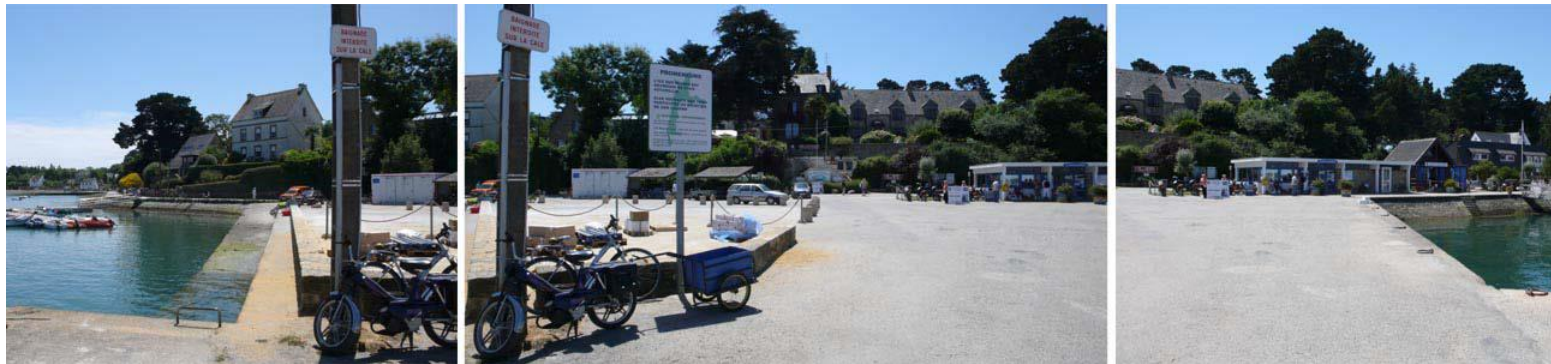
Vues du port de plaisance de l'Île avant travaux
