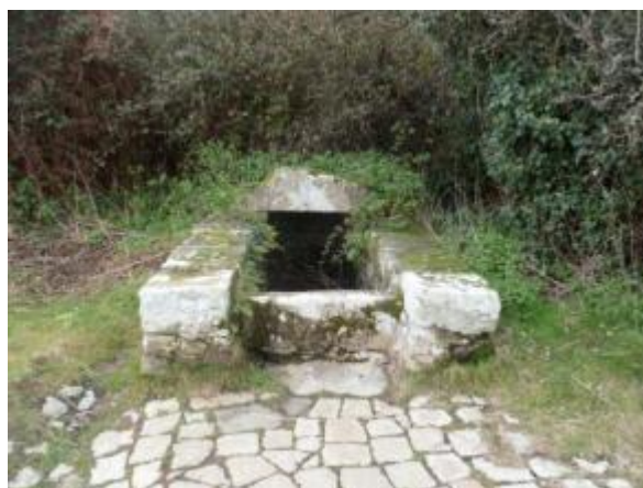
Fontaine aménagée au Nord de la Pointe Perneguy - Artélia
