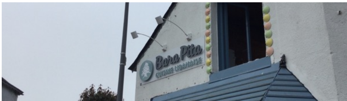
Enseigne parallèle lumineuse (éclairage par projection avec spots), l'Île-aux-Moines, août 2019
