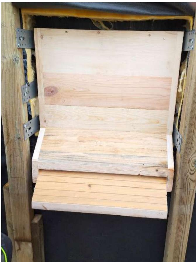
*Photo 7: Intégration d'un nichoir bois dans une nouvelle construction en bardage bois avec isolant sur Crozon – Source Groupe Mammalogique Breton, 2023*
