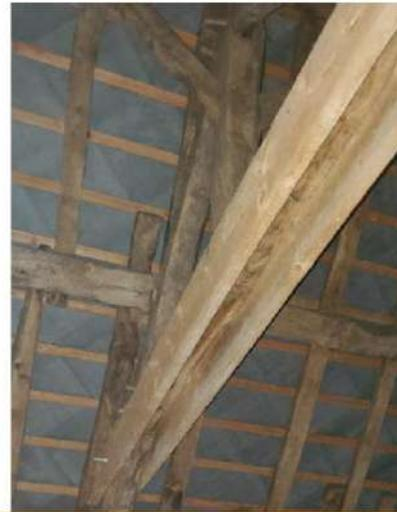
Lorsque les éléments de charpente souffrent du temps, les renforts posés par exemple sur une entrant comme ci-contre permettent de créer des espaces favorables pour les colonies de mise-bas (en témoigne la quantité de guano au sol sous l'aménagement) Saint-Igneuc (22).
