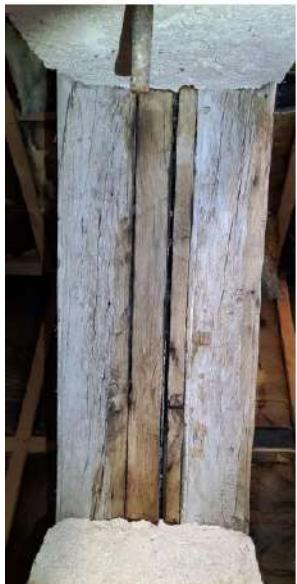
**Linteaux et autres espacements entre pièces de bois** : Il est vivement recommandé de conserver, de réouvrir voir de nettoyer les espaces formés entre les pièces de bois. C'est le cas, des trous de mortaise, des vides dans la maçonnerie formés par la pénétration des pannes ou encore des espaces entre les chevrons.
