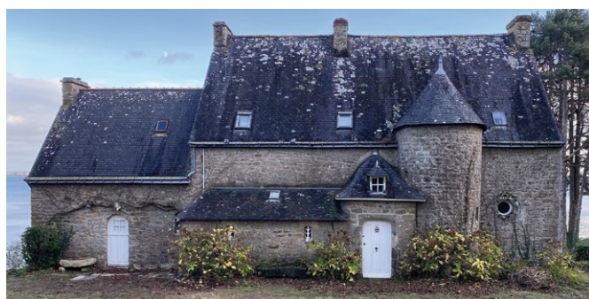
Route du Trec'h (1910).
