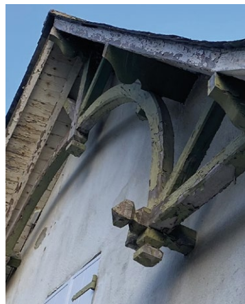
Rue du Rest (1930).
