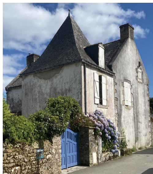
Rue de la Mairie, maison d'origine 1836.
